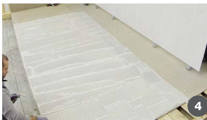
Utilizzando l'apposito telaio a ventose posizionare la lastra sul letto di colla **(5,6)**, facendo attenzione a mantenere una fuga minima di 3mm.
