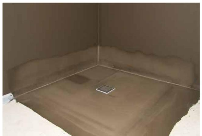
6 Abgedichtete Fläche, bereit für die folgende Fliesenverlegung.
