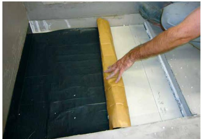
**2** SoproThere® Bitumen-Abdichtungsbahn unterhalb der Duschtasse.
