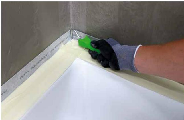
**3** Das Wannenabdichtband lässt sich aufgrund einer senkrechten Perforierung auch in Ecken gut verkleben.
