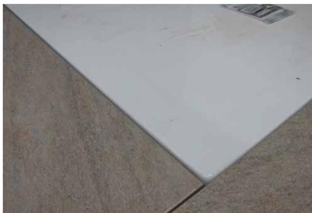
4 Gut erkennbar ist bei der Überprüfung der Höhen, dass der Fliesenbelag und die Duschfläche bündig zueinander sind.
