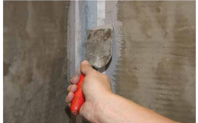
1 Zuerst werden die Ecken mit den vorgeformten Sopro Dichtecken, die Eckfugen und Boden-/Wandanschlussfugen mit Sopro Dichtband abgedichtet. Hierzu wird Sopro FlächenDicht flexibel auf den grundierten Untergrund aufgetragen, das Dichtband eingelegt und am Vliesrand mit Pinsel oder Spachtel satt in die Dichtungsmasse eingebettet.
