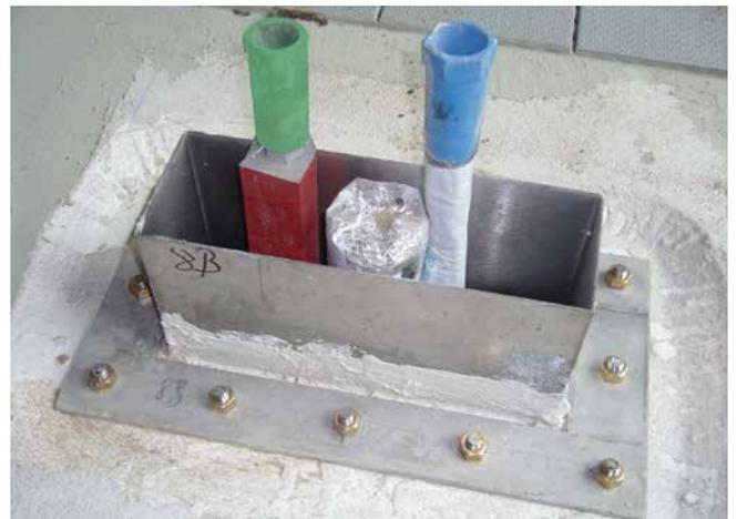
Durchdringungsbauteil mit Pressdichtflansch eingedichtet mit einer Verbundabdichtung.
