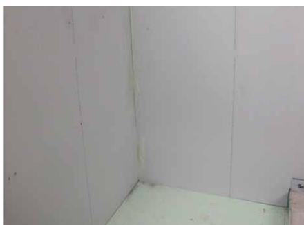
Zementgebundene Trockenbauplatte (System Fermacell).
