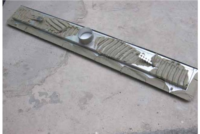
2 Die Rinne ist rückseitig mit Fliesenkleber (Sopro's No.1 S1 Flexkleber) für einen guten Haftverbund zum Estrich abzuspackeln.
