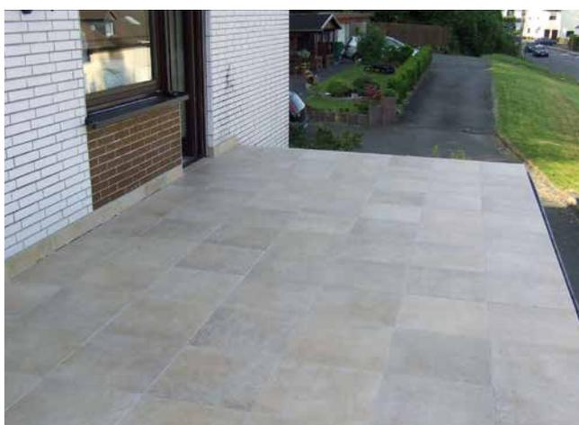
6 Fliesen verlegt mit hochflexiblem Dünnbettmörtel Sopro megaFlex S2 und verfugt mit Sopro FlexFuge plus.
