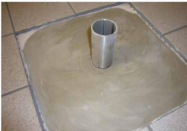
**1** Wie bei Fall 1: Die beschädigte Fliese ist im Bereich der Durchdringung vorsichtig heraus zu nehmen und der Kleber bis auf die Abdichtung abzuschleifen. Es ist darauf zu achten, dass eine Übergangszone in der Abdichtungsebene für die Neuabdichtung berücksichtigt wird.
