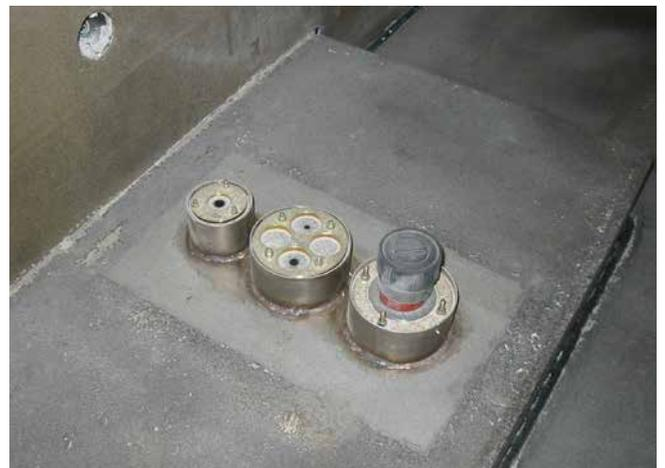
Durchdringungsplatte mit Gummidichtungsringseiben.
