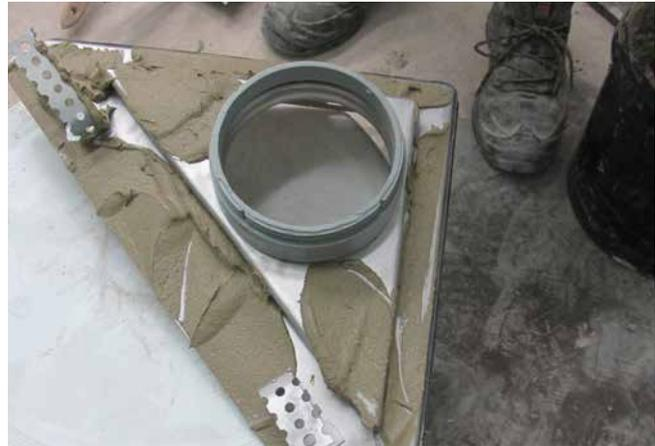
2 Zur Herstellung eines guten Haftverbundes zwischen Estrichmörtel und Eckentwässerungselement wird dieses rückseitig mit Sopro's No.1 S1 Flexkleber abgespachtelt.
