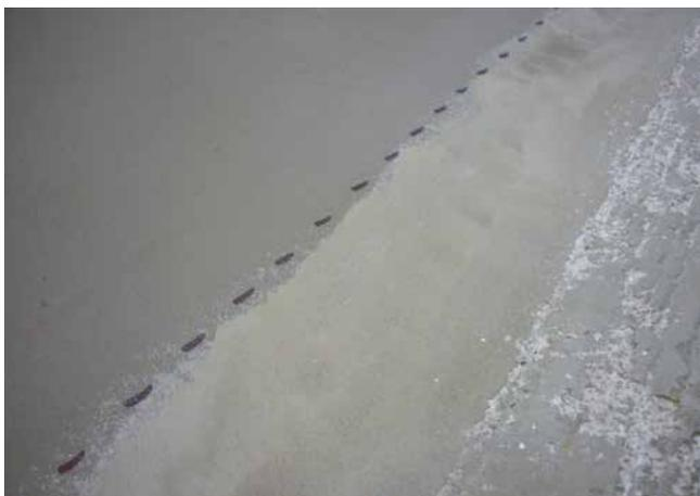
**3** Optimal vorbereitete Übergangzone für den Anschluss der neuen Verbundabdichtung.
