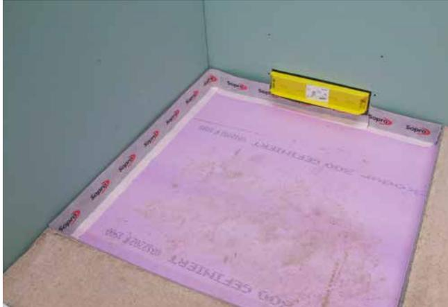
1 Wandeinlaufelement für Trockenbau- und Mauerwerkskonstruktionen (System Geberit) in Kombination mit schwimmender Estrichkonstruktion.
