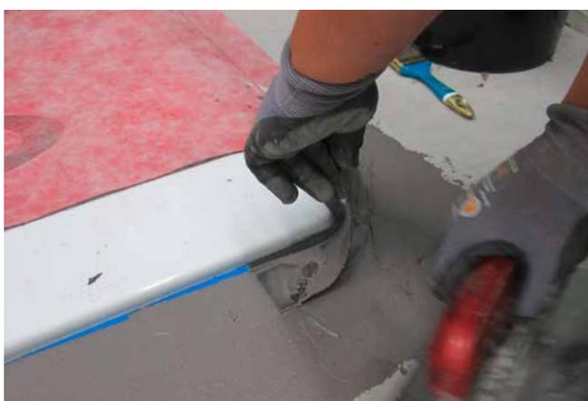
5 Umlaufend werden die Dichtbandflansche in die flüssige Flächenverbundabdichtung eingearbeitet.
