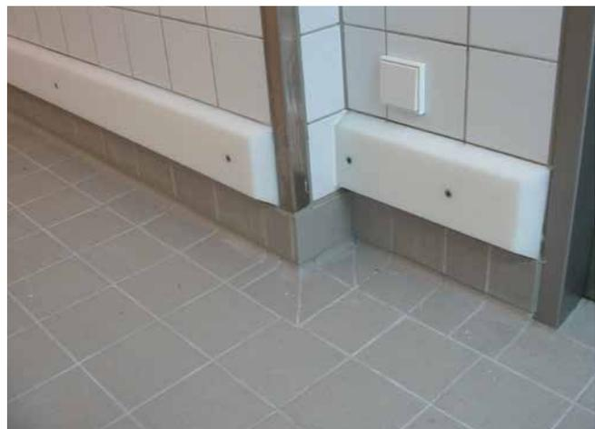
Ausgeführtes Sockeldetail mit Prallschutz.
