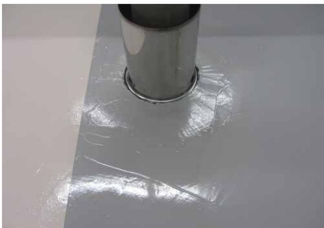
5 Mittels Sopro FlächenDicht Kontrastfarbe lässt sich die zweite Schicht Sopro PU-FlächenDicht einfärben. Das Arbeiten wird durch diese Sichtkontrolle erleichtert.
