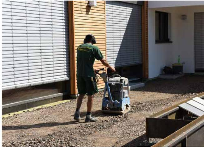
Verdichten der ungebundenen Trag- und Frostschutzschicht.
