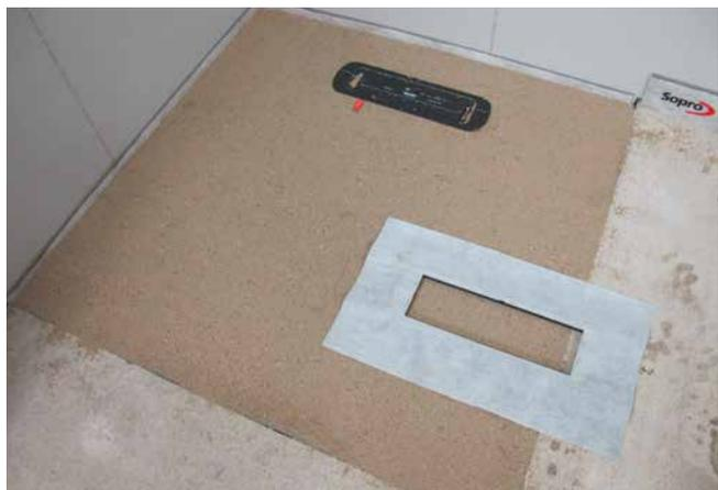
6 Fertig hergestellte Fläche, bereit für die folgenden Abdichtarbeiten.
