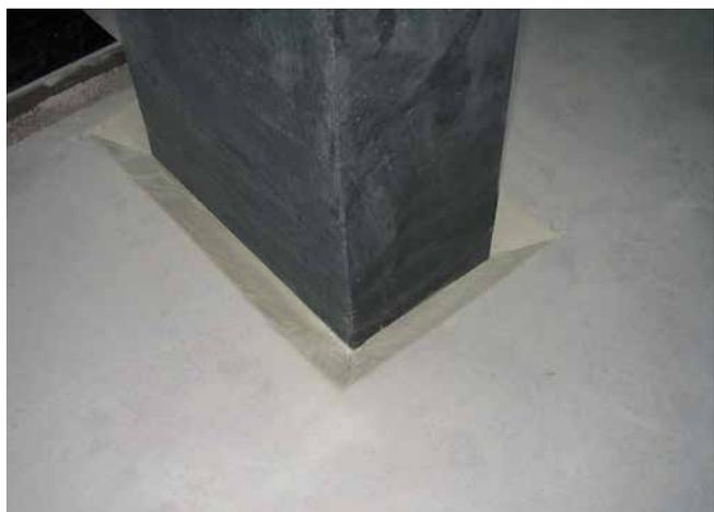
Ausgesparter Estrich an einer Stütze zur sockelfreien Anbindung der Abdichtung.
