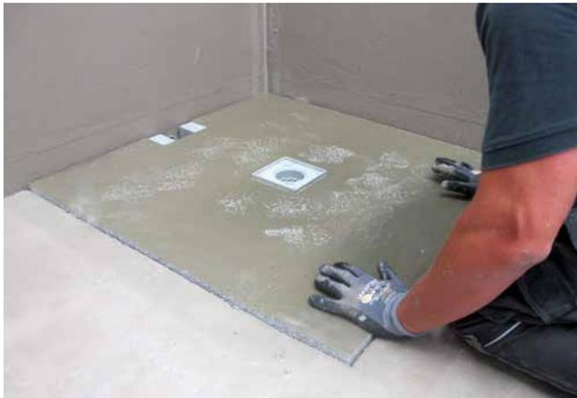
**3** Einsetzen des Poresta-Duschelementes in das frische Kleberbett. Nach dem Eindichten des Elementes mit Sopro DichtSchlämme Flex 1-K kann mit der Fliesenverlegung begonnen werden.
