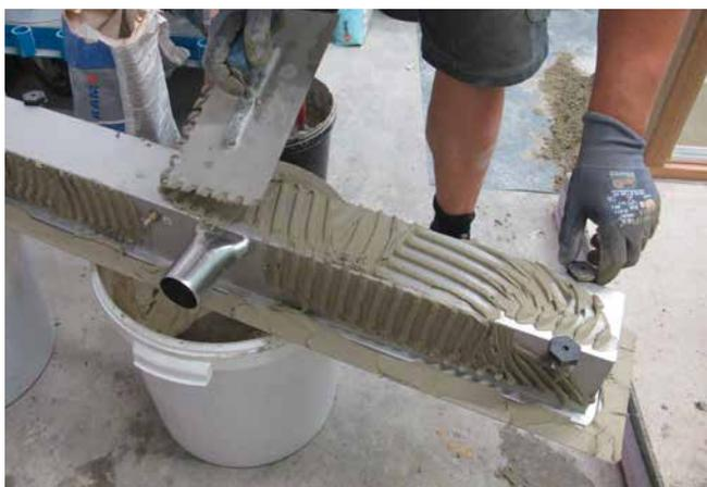
**3** Für den besseren Haftverbund zum Estrich wird die Rinne außen-seitig mit Dünnbettmörtel abgespachtelt.
