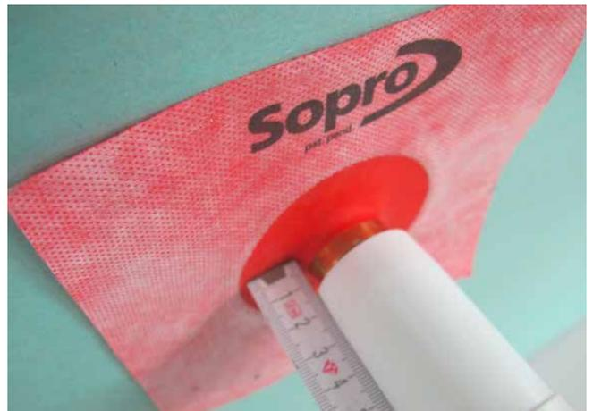
Die Konstruktion von Geberit ist so einstellbar, dass das Anschlussrohr zur Anarbeitung der Dichtmanschette genügend weit aus der Wand herausragt.
