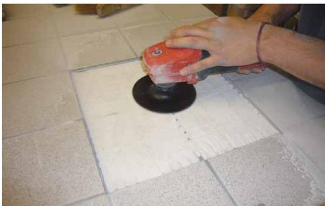
**5** Damit das Verlegen der neuen Fliese nicht mit einem Höhenversatz bzw. Überzahn ausgeführt wird, ist der alte Kleber mit einer Sandpapierscheibe von der Abdichtung herunter zu schleifen. Ist dies geschehen, kann mit der Neuverlegung der Fliesen begonnen werden.
