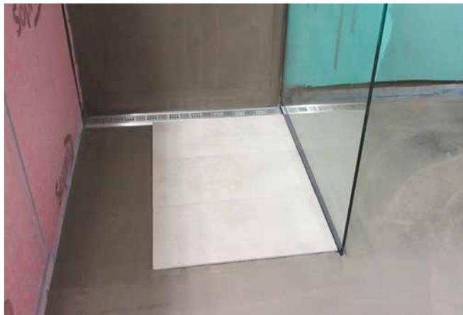
6 Die Abdichtung des Bodens erfolgte mit Sopro TurboDicht-Schlämme 2-K. Zur Bewertung der Einteilung der Fliesen sind bereits einige Fliesen in der Duschfläche ausgelegt.
