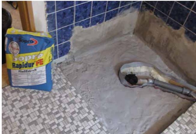
2 Herstellen einer planebenen Verlegefläche mit Sopro Rapidur® FE FließEstrich für die sichere, vollflächige Verlegung des Duschelementes.
