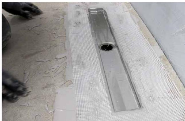
**2** Einlage einer Armierungsgewebemanschette zur Verstärkung der Verbundabdichtung (Sopro DichtSchlämme Flex 1-K) im Übergangsbereich vom Flansch zum Estrich.
