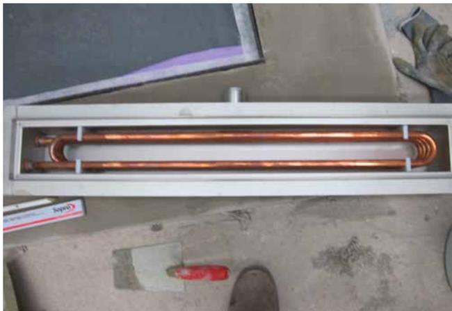
**1** ACO Rinne mit Wärmetauscherkupferleitung zur Energieeinsparung. Über die Rinne findet eine Wärmerückgewinnung statt.
