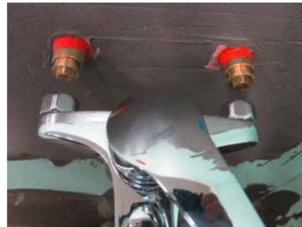
Aufputzarmaturen sind in vielen Duschen und Nassbereichen immer noch Standard, die genormten Maße der Anschlüsse lassen sich mit einer Manschette sicher eindichten.
