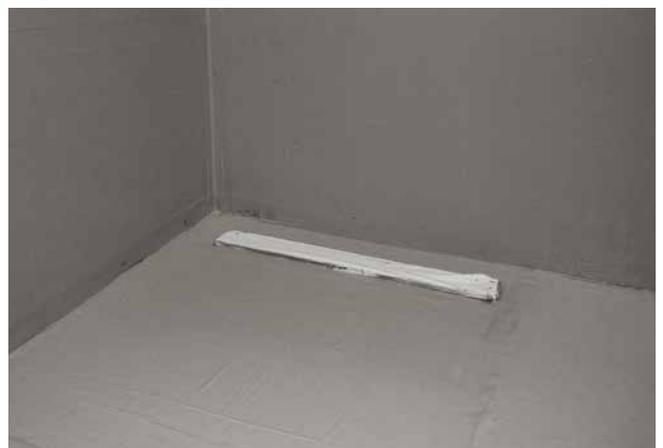
6 Komplet abgedichtete Duschecke in zwei Arbeitsgängen (Wand- und Bodenfläche) mit Sopro DichtSchlämme Flex 1-K, bereit für die folgende Fliesenverlegung.
