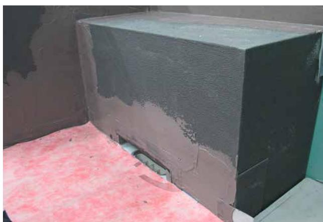
6 Schedel bietet für die Xetis-Wanne auch eine Sitzbanklösung, die für eine Badgestaltung sehr interessant sein kann. Die Entwässerung der Xetis-Wanne wird über das Schedel-Element geführt. Alle Flächen werden mit Sopro TurboDichtSchlämme 2-K abgedichtet.
