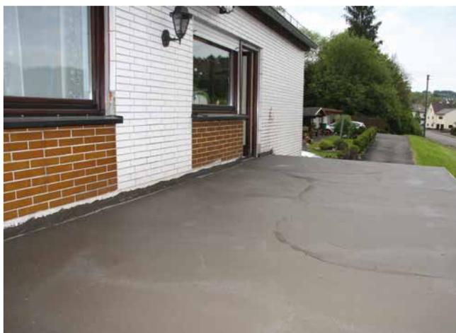
4 Abgedichtete Balkonfläche mit Sopro TurboDichtSchlämme in zwei Arbeitsgängen mit einer Gesamttrockenschichtstärke von 2 mm.
