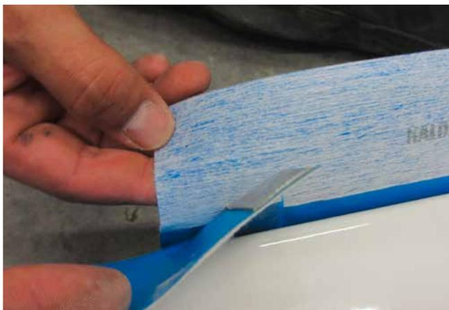
3 Bänder und Ecken werden überlappend durch eine Kleberschicht wasserdicht miteinander verleimt.
