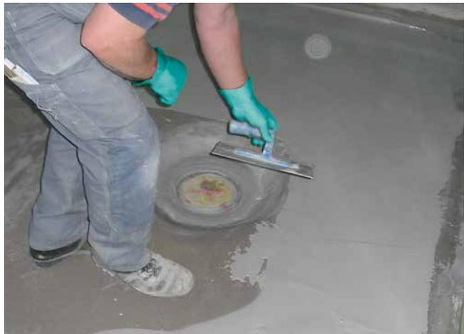
Applikation der flexiblen, mineralischen Dichtungsschlämme.
