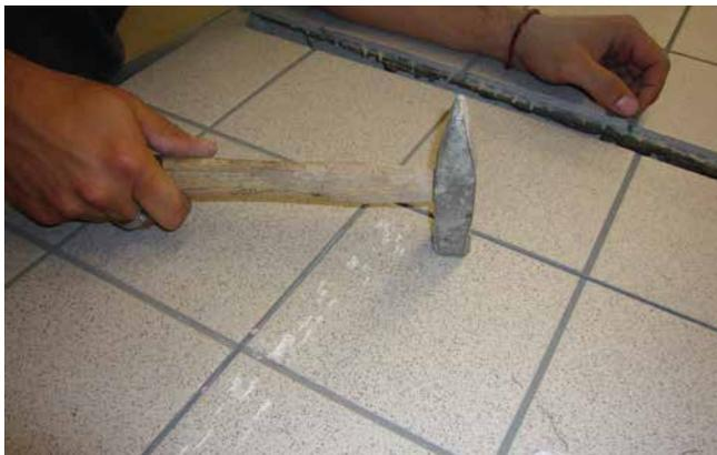
**3** Ist die Fuge eingeschnitten, wird die Fliese mit einem Hammer und leichten Schlägen zertrümmert. Die Einzelstücke der Fliese werden entfernt.
