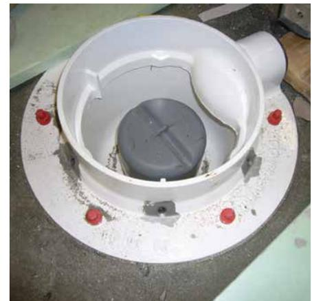
Entwässerungstopf zur Zwischenentwässerung einer Abdichtungsebene.
