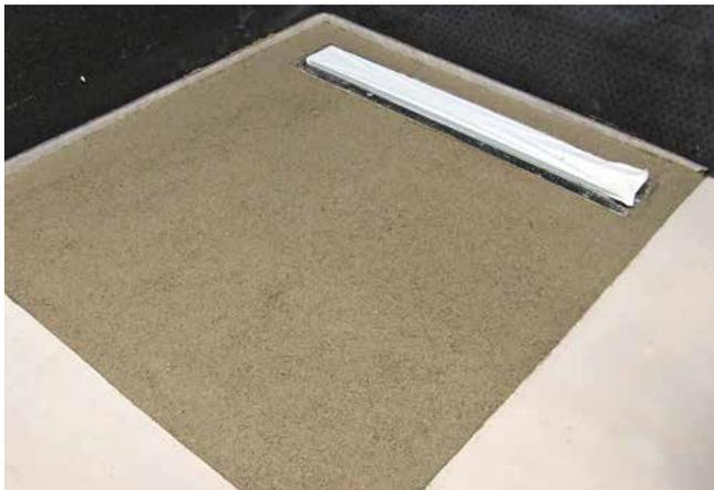
3 In den Estrichmörtel (Sopro Rapidur® M1/Sopro Rapidur® M5) fertig eingebaute ACO-Rinne.
