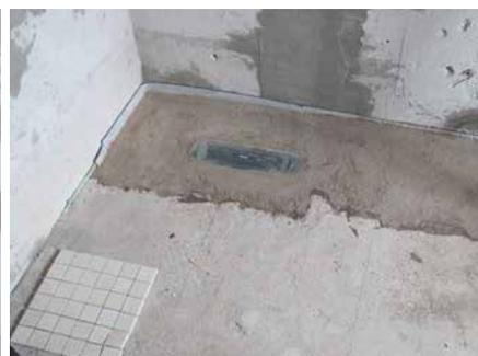
Duschfläche hergestellt aus Zementmörtel (Sopro Rapidur® B5).
