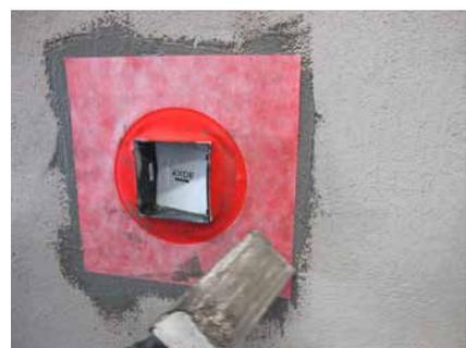
Je nach Einbauteil sind auch abgestimmte Manschettenlösungen möglich.
