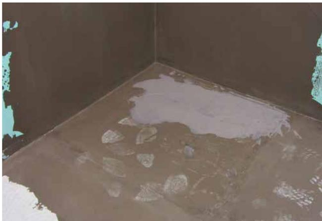
Aufgrund des Deckenaufbaus ist eine Versenkung der Duschtasse in den Boden nicht möglich. Die Boden- und Wandflächen sind mit einer Verbundabdichtung (z. B. Sopro DichtSchlämme Flex 2-K) abgedichtet.
