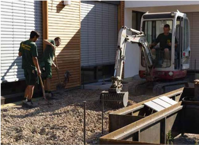
Einbau der ungebundenen Frostschutzschicht.
