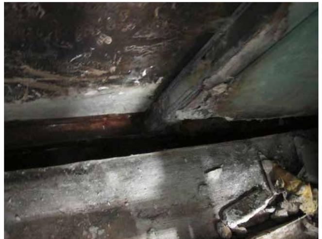
Schimmelbefall in einer Trockenbaukonstruktion mit Gipskarton.
