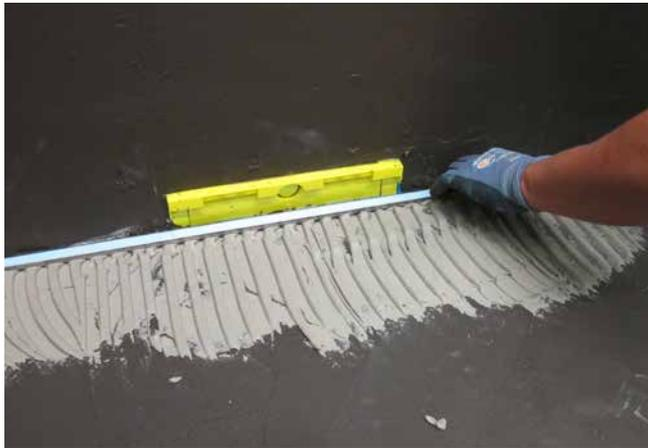
**7** Vor dem Wandeinlaufelement wird eine Wassersammelschiene vollsatt mit Fliesenkleber (Sopro's No.1 S1 Flexkleber) auf der Verbundabdichtung verklebt.
