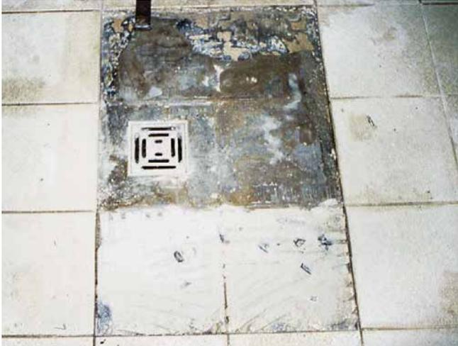
Fehlende Anschlussmöglichkeit der Verbundabdichtung an das Aufstockelement des Bodenablaufes.
