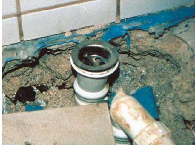
Undichtigkeit eines Tauchbeckens durch falschen Bodenablauf (Waschbeckenablauf). Flansch für die Flächenabdichtung fehlt.
