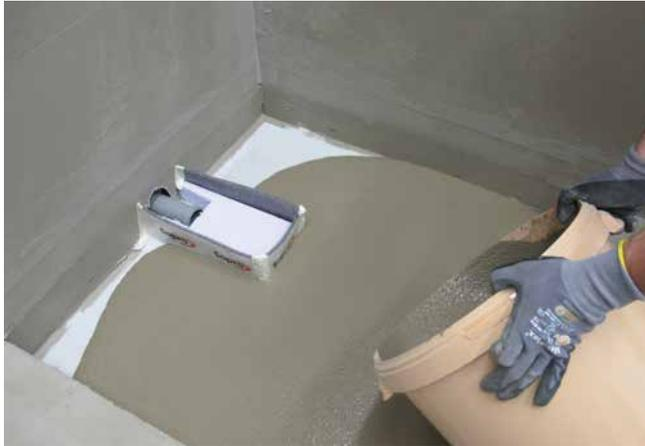
**1** Herstellen einer planebenen Verlegefläche mit Sopro Rapidur® FE FließEstrich zur sicheren Aufnahme des Duschelementes.
