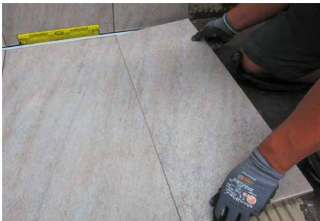
**9** Die Fliesen werden an der Wassersammelschiene angearbeitet.
