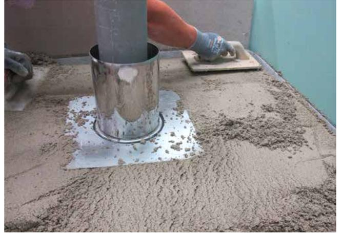
2 Einbau des lastverteilenden Zementestrichs mit dem zweiten Hüllrohr, welches im Estrich fixiert ist und Hüllrohr 1 umschließt.
