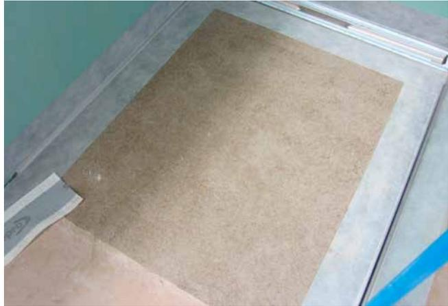
2 Die Rinne ist mit Sopro Rapidur®M1/Sopro Rapidur®M5 versetzt. Anschließend erfolgt die Verklebung der Dichtbänder.
