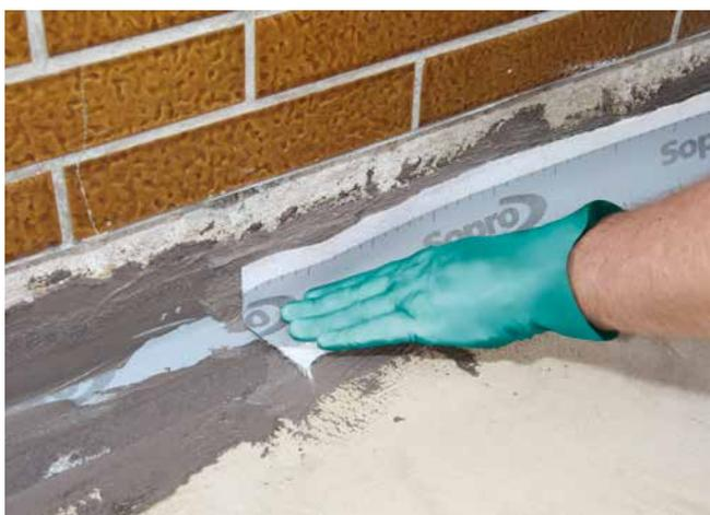
3 Einarbeitung und Fixierung der Dichtbänder und Formteile mit Sopro TurboDichtSchlämme zu Beginn der Abdichtarbeiten.
