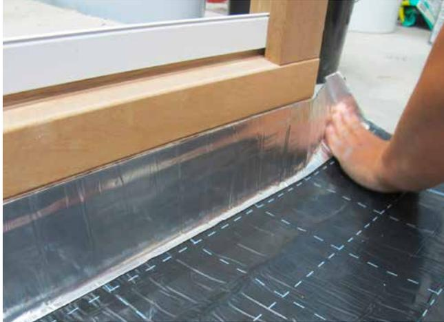
1 Bahnabdichtung mit SoproThene Abschlussband Aluminium am Türelement.
