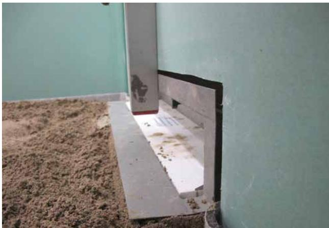
3 Setzen des Rinnenkörpers bündig mit der Wand in den Estrichmörtel (Sopro Rapidur® M1/Sopro Rapidur® M5).
