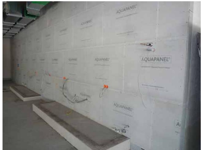
Zementgebundene Trockenbauplatten im Großkundenbereich.
