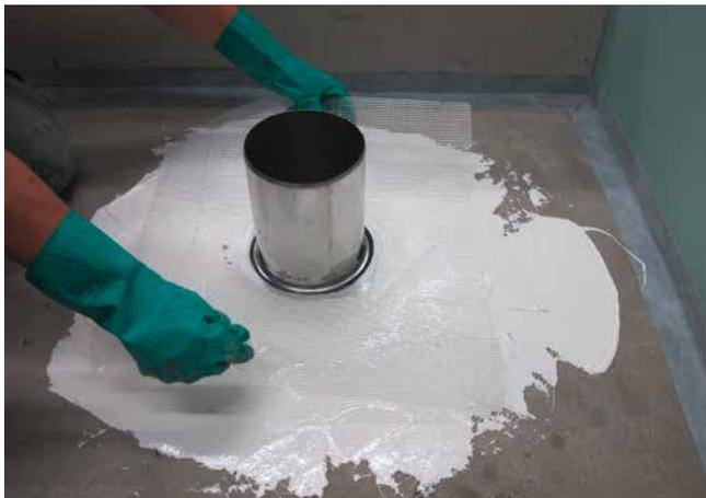
3 Das Hüllrohr wird nach den Grundierarbeiten mit Sopro Epoxi-Grundierung und der Quarzsandabstreung mit Sopro PU-FlächenDicht abgedichtet. Im Bereich der Durchdringung wird die Abdichtung durch eine Gewebeeinlage verstärkt.
