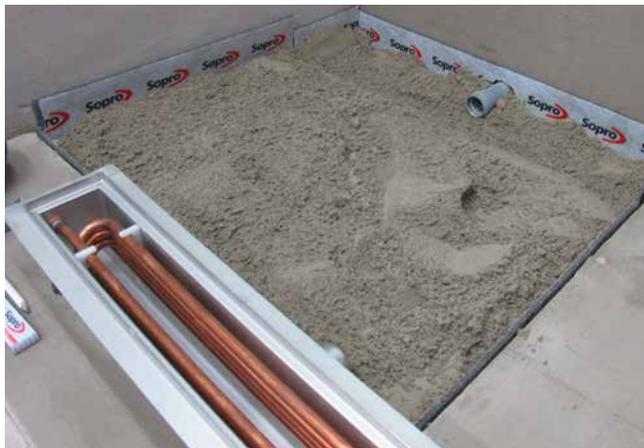
**2** Versetzen der Rinne in den Zementestrich, hergestellt mit Sopro Rapidur® M1/Sopro Rapidur® M5.
