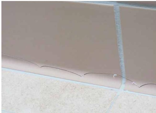
Hohlkehlsockelfliese mit dem langen Schenkel an der Wand verlegt, führt schnell zu Brüchen im unteren Bereich der Fliese.
