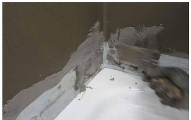
**2** Die Dichtecke lässt sich z. B. mittels Sopro DichtSchlämme Flex 1-K leicht in der Raumecke einarbeiten.
