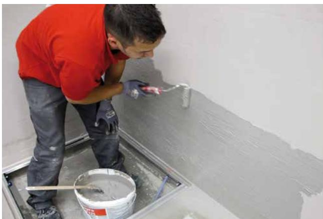
4 Zur Abdichtung der Flächen wird Sopro FlächenDicht flexibel mit einer Lammfellrolle oder einer Glättkelle satt und porenfrei auf den Untergrund aufgetragen. Nach ausreichender Festigkeit der ersten Schicht wird die zweite Schicht mit einem weiteren Farbton aufgetragen. Nach Erhärtung der zweiten Schicht kann der Fliesenbelag mit flexiblem Dünnbettmörtel (z.B. Sopro's No. 1 S1 Flexkleber) verlegt werden.
