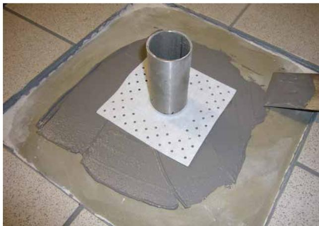
**2** Die Rohrdurchdringung wird durch eine Dichtmanschette eingefasst. Diese wird in das Verbundabdichtungsmaterial eingearbeitet.
