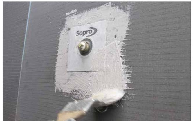
2 Die Sopro Dichtmanschette Wand wird über den Rohrstützen gestülpt.
