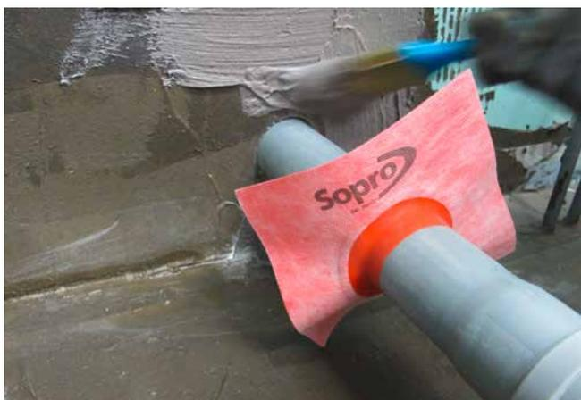
Rohre für die Entwässerung lassen sich mittels der Sopro AEB® Wandmanschette 130 sicher eindichten.
