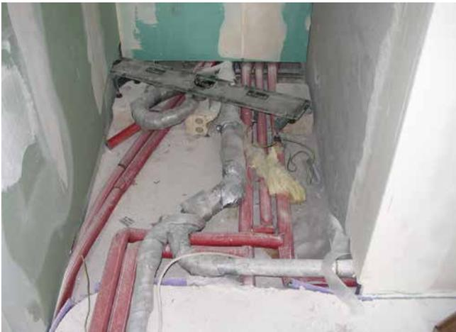
Die Führung von Versorgungsleitungen in den ausgesparten Bereichen erschweren den Abdichtungsprozess. Nach DIN 18534 ist dies zukünftig zu vermeiden.
