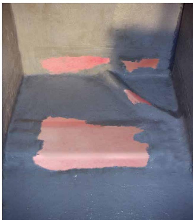
Ergänzung der Verbundabdichtung durch Einarbeiten von Sopro AEB® Abdichtungs- und Entkopplungsbahn-Teilstücken im Bereich der Rohre und Installationen. Dabei werden die Enden der Teilstücke vollsatt in die flüssig zu verarbeitende Verbundabdichtungs- masse eingearbeitet und überarbeitet.
