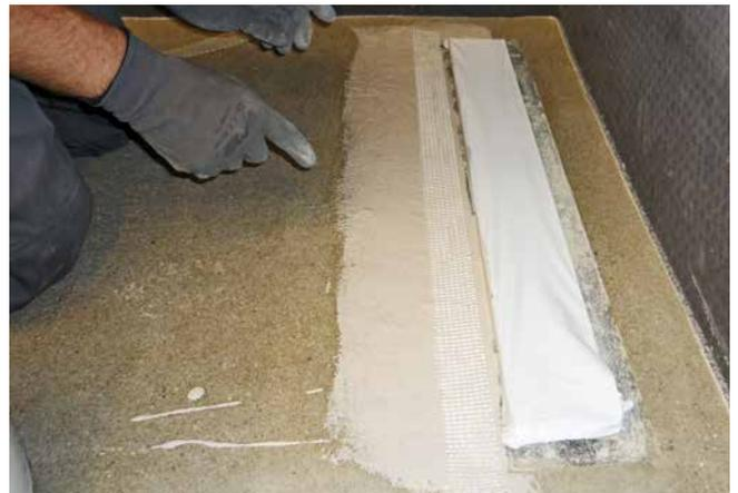
4 Eindichten des Rinnekörpers mit Sopro DichtSchlämme Flex 1-K. Der Übergang wird durch Einlegen eines Armierungsgewebestreifens in die Verbundabdichtung verstärkt.
