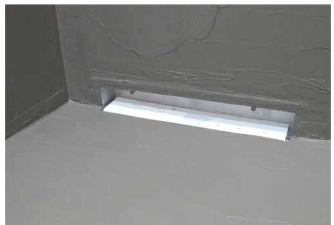
6 Abgedichtete Duschfläche, bereit für die folgende Fliesenverlegung.
