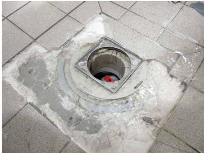
Werkseitig montierter Dichtflansch wurde, weil er störte abgeschnitten. Die Folge: Keine Anschlussmöglichkeit zur Dichtungsschlämme mehr möglich.
