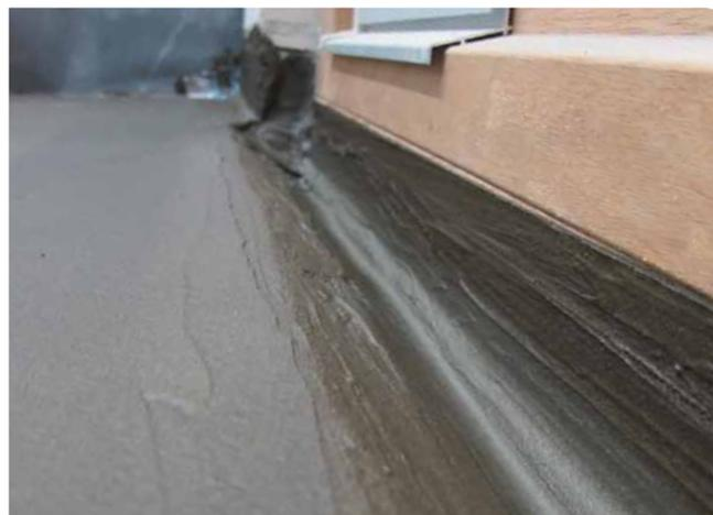
4 Abgedichtete Balkonfläche mit Anschluss an das Türelement.
