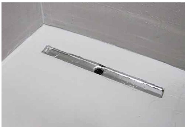
**3** In zwei Arbeitsgängen abgedichtete Duschecke mit Sopro DichtSchlämme Flex 1-K.
