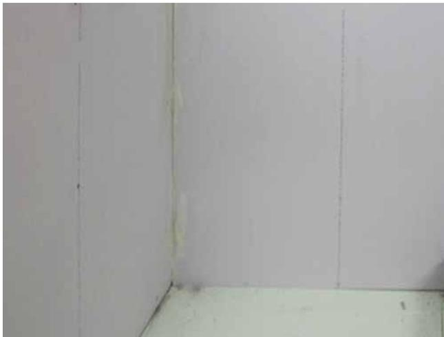
Zementgebundene Trockenbauplatten für den Bau von Wänden in einer Dusche.
