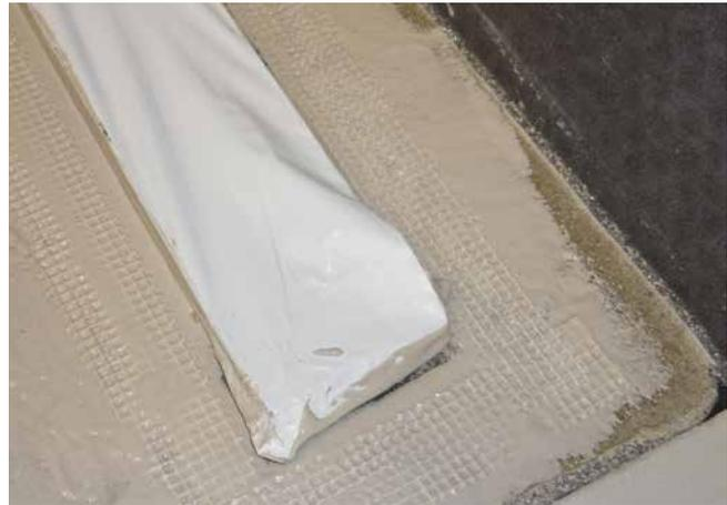
**4** Einbetten von Sopro Armierung in die Sopro DichtSchlämme Flex 1-K im Bereich von Flanschen als Übergangverstärkung.
