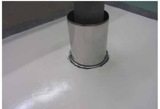
4 Mit Sopro PU-FlächenDicht eingedichtetes Hüllrohr.
