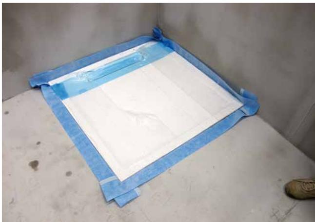
1 Duschtassenelement mit angeklebten Dichtbändern (Systemkomponente), welche ein Anarbeiten an die Verbundabdichtung ermöglichen.
