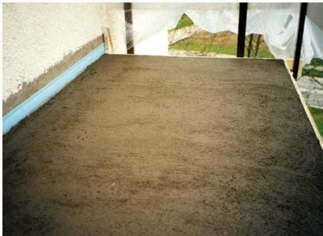
2 Mit Gefälle vorbereitete Fläche zur Aufnahme der Verbundabdichtung (Sopro TurboDichtSchlämme).
