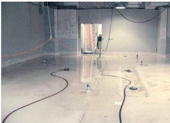
Prüfung der Bodenabdichtung auf Dichtigkeit durch Flutung.
