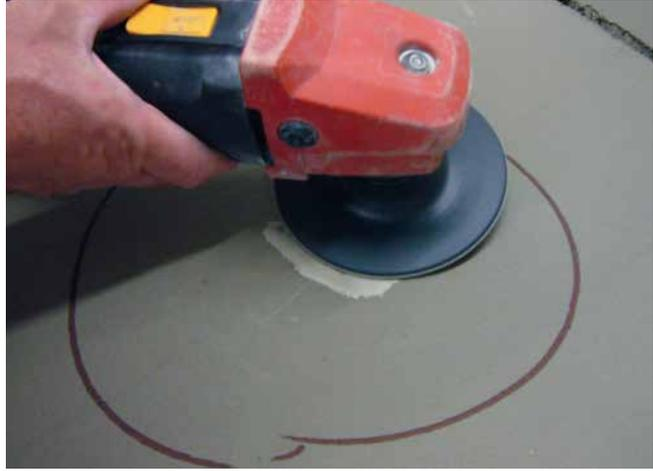
Anschleifen der Schnittkanten zur Herstellung einer Übergangszone.
