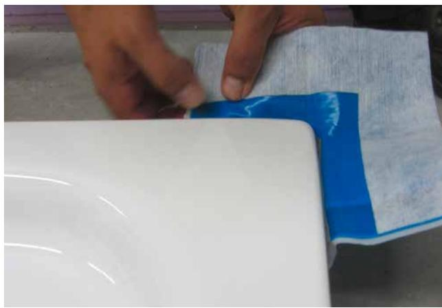
2 Eine Anbindung zwischen Wannenrand und Abdichtungsmasse (Sopro DichtSchlämme Flex) ist gegeben.
