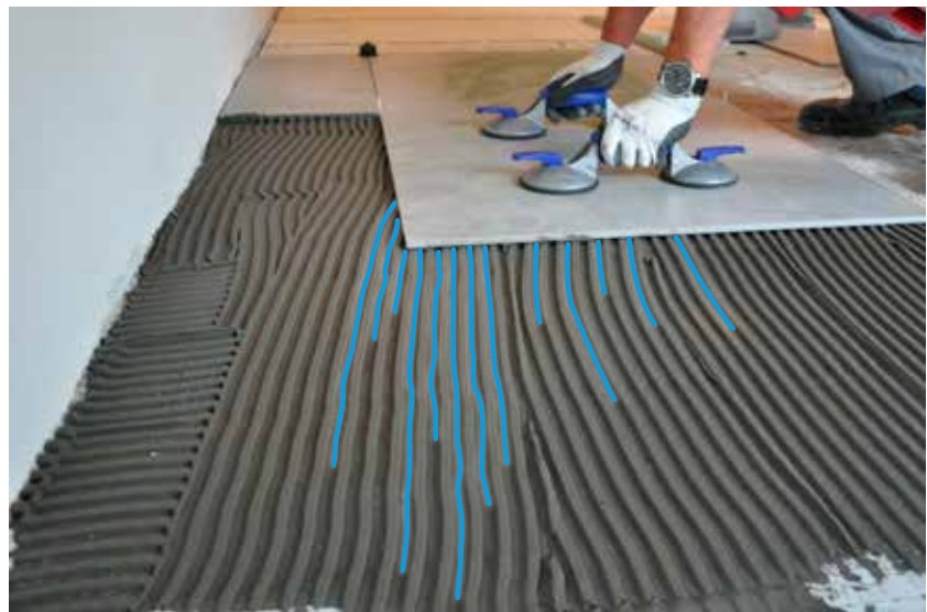
Kleberkanäle durch Zahnkamm bei einseitigem Kleberauftrag (Floating-Verfahren)
