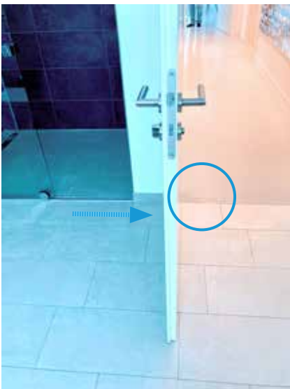
Dusche bodeneben - direkte Lage neben dem Türrichtungsbereich
